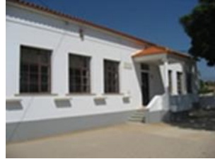
EB 1 da Estação
